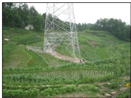
图 5-1 铁塔长短腿与不等高基础配合使用设计以及现场图
